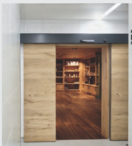
A porta controlada por sensor entre a cozinha e o restaurante
